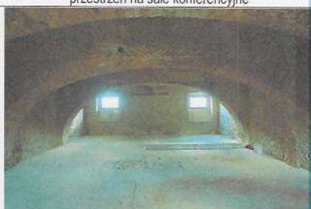
Piwnice – planowane magazyny destylatu
